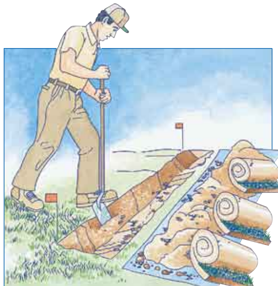
Zuerst sind Planen auf den Boden zu legen und die Grassoden abzustechen, dann 25 bis 30 cm tiefe Gräben für die Hauptleitung auszuheben. Für die Nebenleitungen sind 15 bis 20 cm tiefe Gräben auszuheben.
