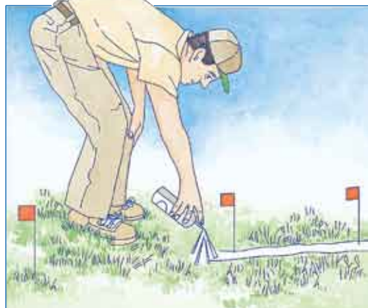
Vor dem Ausheben der Gräben ist der Verlauf des Bewässerungssystems mit kleinen Fähnchen oder Markierungsspray zu kennzeichnen.
