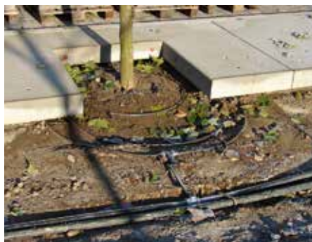
Im 10 cm starken Hohlraum zwischen dem Baumsubstrat und den Wurzelbrücken wurde das Bewässerungssystem verlegt.
