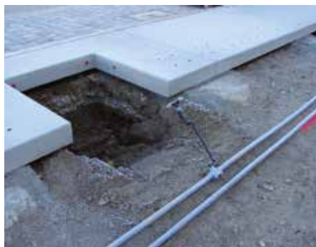
Im Baukastensystem konnte die Tröpfchenbewässerung für die Bäume verlegt werden.
