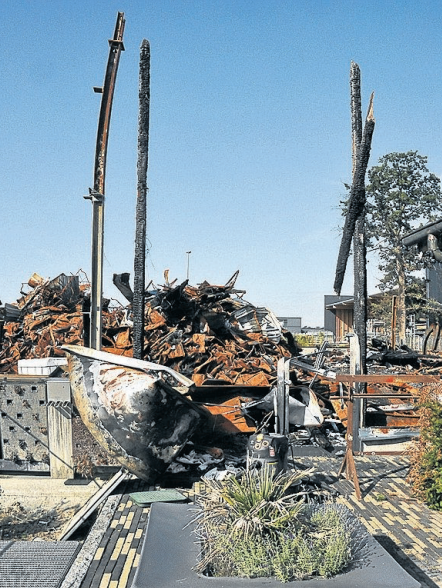
Wie Strohhalme stehen die verbogenen Eisenträger noch als stumme Zeugen am Brandort.
