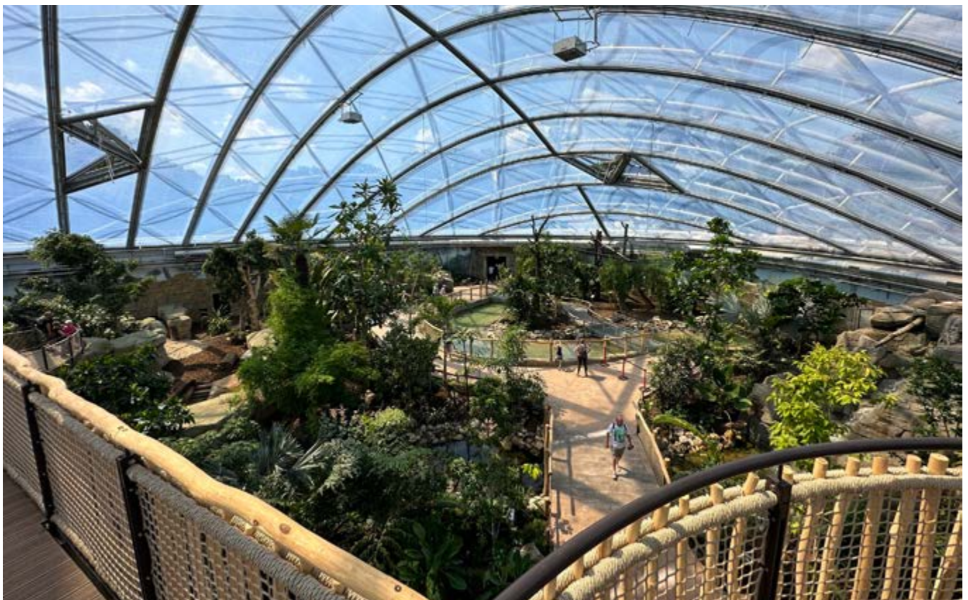
Foto: Allwetterzoo Münster; Sprühdüsenbewässerung
